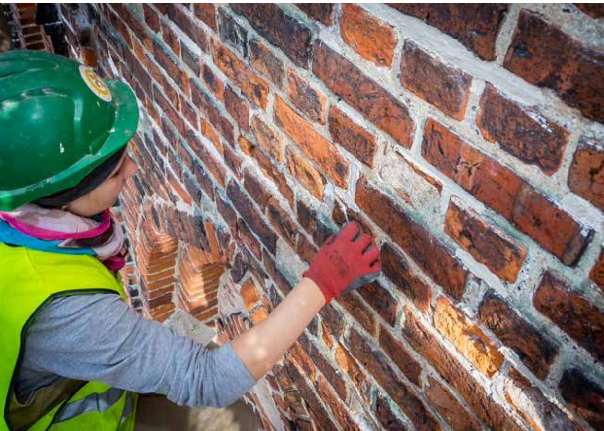
Fasādes ķieģeļu šuvošana.
